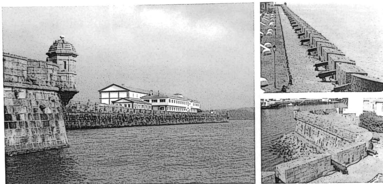
Tres imaxes do dique de abrigo-batería parque (La Cortina).
